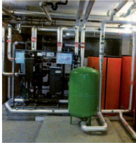
Wohl der Gäste. Die neue Warmwasserstation ist auf dem aktuellen Stand der Technik und erfüllt die Forderungen der neuen Trinkwasserverordnung. Die moderne Station verhindert das Wachstum von Legionellen und hält auch das Rohrnetz frei von diesen Keimen.
